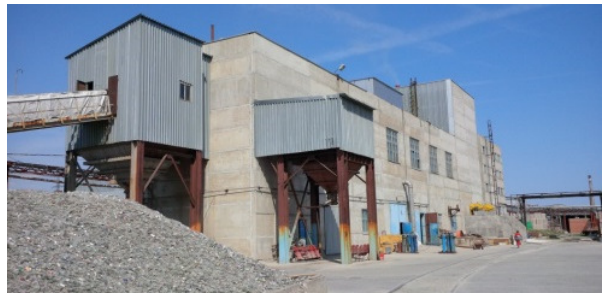
Bild: Firma ACTIS, Glasaufbereitungsanlage
