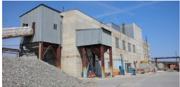
Bild: Firma ACTIS, Glasaufbereitungsanlage
